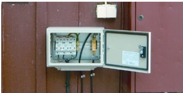
Exempel på inledningsskydd för el och tele.
