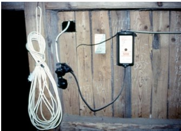
Elstängselapparat får inte placeras på en oskyddad trävägg.
