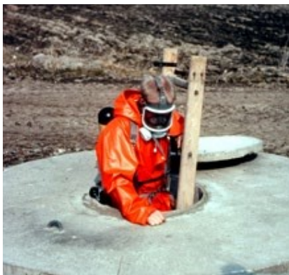
Jobb i pumpgropar, urinbrunnar, tornsilor och liknande kräver alltid andningsskydd med friskluft och i många fall även hel skyddsdräkt.
